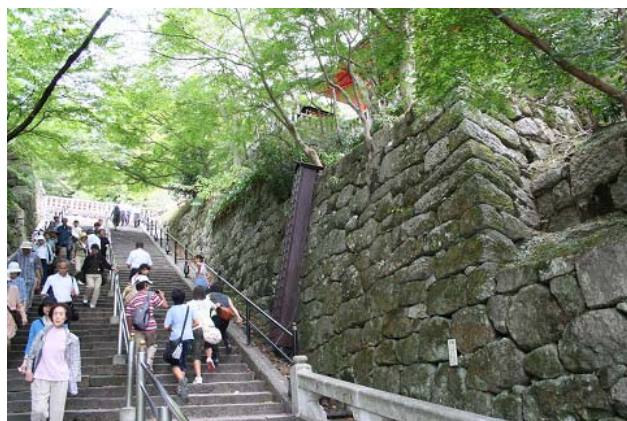
写真1 参道に接する石積み擁壁
