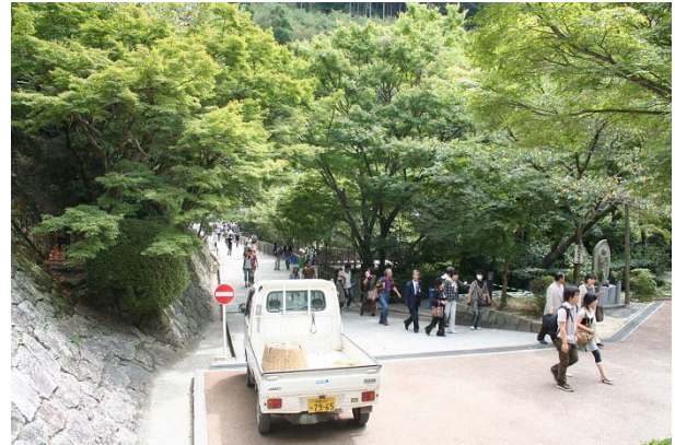
写真2 轟門下の石積み擁壁に接する参道
